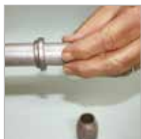
Introduzir a Junta de Vedação no Eletroduto.
